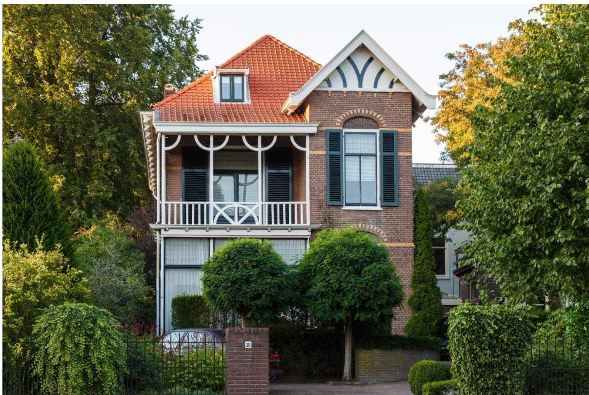
Voorgevel Villa Middelharnis– 2016
