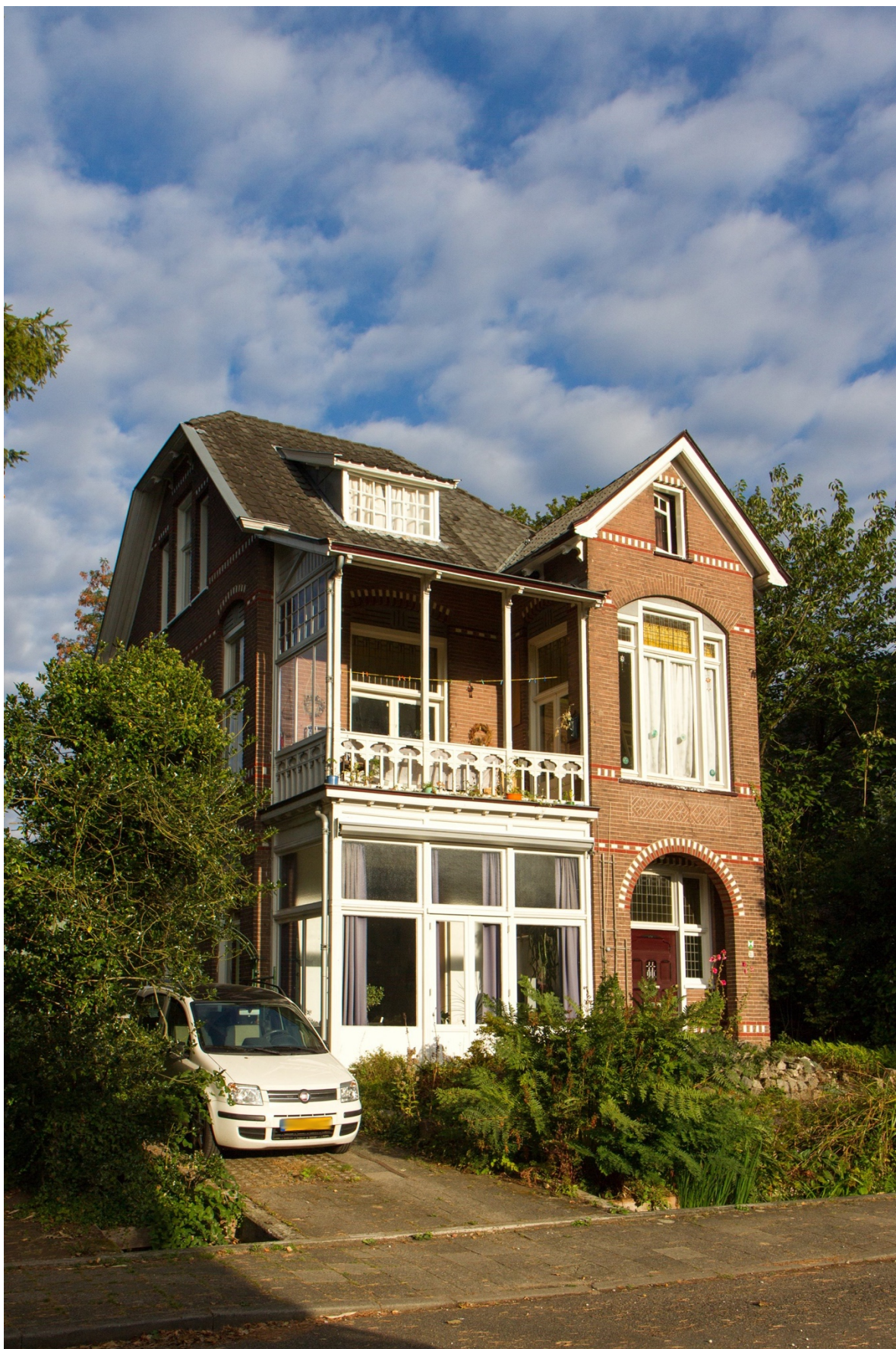
Voorgevel en linkerzijgevel - 2016 Foto: Marjo Hendrix / fotoclub Veluwezoom © CC BY-NC-ND
