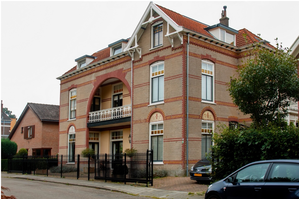
Voor en rechterzijgevel – 2016
