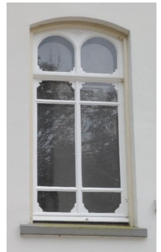
Detail raam noordgevel, 2024 (foto auteur)
